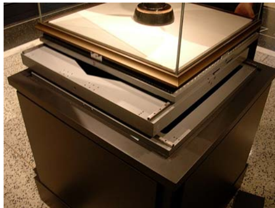
Koumouis Abb. 1: Ein kleiner Getty-Isolator unter einem Ausstellungs-Schaukasten im Getty Museum. Rechts sieht man den Isolator in verschobener Position ohne die Schutzabdeckungen.
