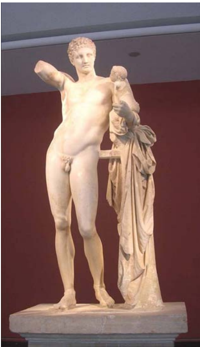
Koumouisis Abb. 3: Die monumentale Marmorstatue des Hermes, aufgestellt im neuen Archäologischen Museum in Olympia. Die Statue ist durch einen Sockelisolationsmechanismus isoliert, der in einem Hohlraum im Boden eingebaut ist. Rechts sieht man die Stützplattform, auf der die Statue und ihr Sockel ruhen. Achten Sie auf den ausreichenden Raum zwischen den Kanten der Plattform und die Schutzschiene rund um die Ausstellungsanordnung, welche die Seitwärtsbewegungen der Basisisolationseinheit (und der Skulptur) auffängt.
