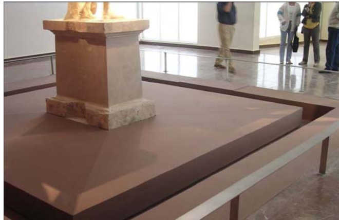
Koumouisis Abb. 3: Die monumentale Marmorstatue des Hermes, aufgestellt im neuen Archäologischen Museum in Olympia. Die Statue ist durch einen Sockelisolationsmechanismus isoliert, der in einem Hohlraum im Boden eingebaut ist. Rechts sieht man die Stützplattform, auf der die Statue und ihr Sockel ruhen. Achten Sie auf den ausreichenden Raum zwischen den Kanten der Plattform und die Schutzschiene rund um die Ausstellungsanordnung, welche die Seitwärtsbewegungen der Basisisolationseinheit (und der Skulptur) auffängt.
